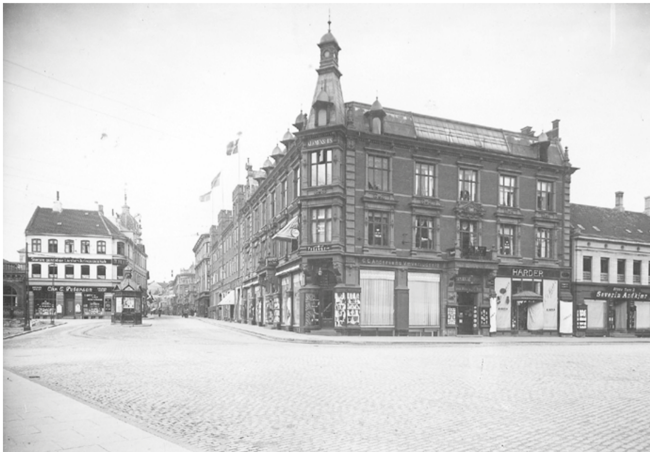
Klemenshus. Den pragtfulde forretnings- og beboelsesejendom i nyrenæssancestil på hjørnet af Store Torv og Sct. Clemens Torv blev bygget i 1891 og nedrevet i 1935. Hammerschmidt Foto 1922, Den Gamle Bys fotoarkiv
