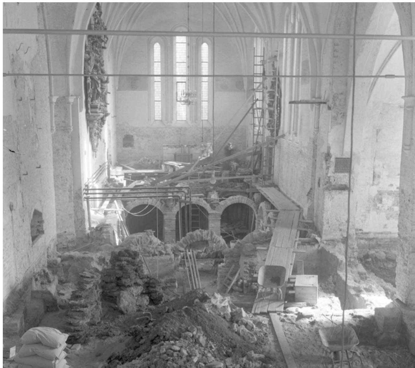
Da man 1955 genopdagede den knap 900 år gamle krypt under Vor Frue Kirke, havde man i nogle årtier været opmærksom på, at koret's gulv muligvis gemte på en overraskelse. I klostergården, på kirkens nordside, havde man således fundet en tilmuret dør, der tilsyneladende førte ned under koret, og på sydsiden havde fjernelsen af vildvin og efeu afsløret tre tilmurede vinduer i jordhøjde. Fotograf Børge Venge, 12. marts 1957. Århus Stiftstidendes billedsamling, Erhvervsarkivet, leveret af Aarhus Stadsarkiv.
