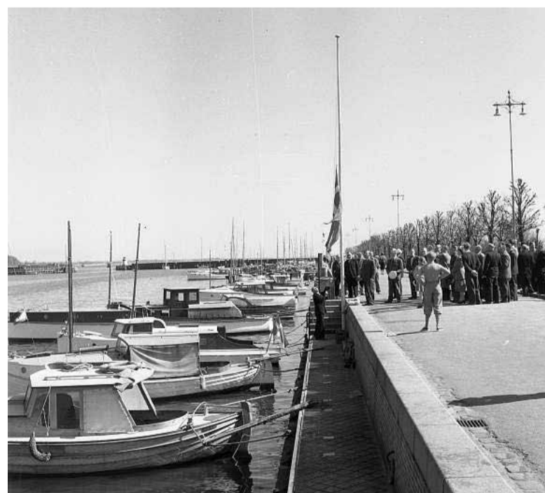
Anlæggelsen af lystbådehavnen var et omfattende havneprojekt. Lystbådehavnen blev begrænset mod havet af et 890 meter langt kystværn. Den fik en 103 meter lang østre dækmole og en 145 meter lang vestre dækmole. Det østre bolværk var indvendigt 465 meter langt, det vestre bolværk 137 meter langt og mod syd var bolværket 54 meter. Havnebassinet var omkring 4 meter dyb. Lystbådehavnen er hjemsted for flere forening, her i blandt Aarhus Motorbådsklub, der på billedet har standerhejsning i forbindelse med indvielsen af sæsonen i maj 1954. Foto: Børge Venge, 1954, Aarhus Stadsarkiv.
