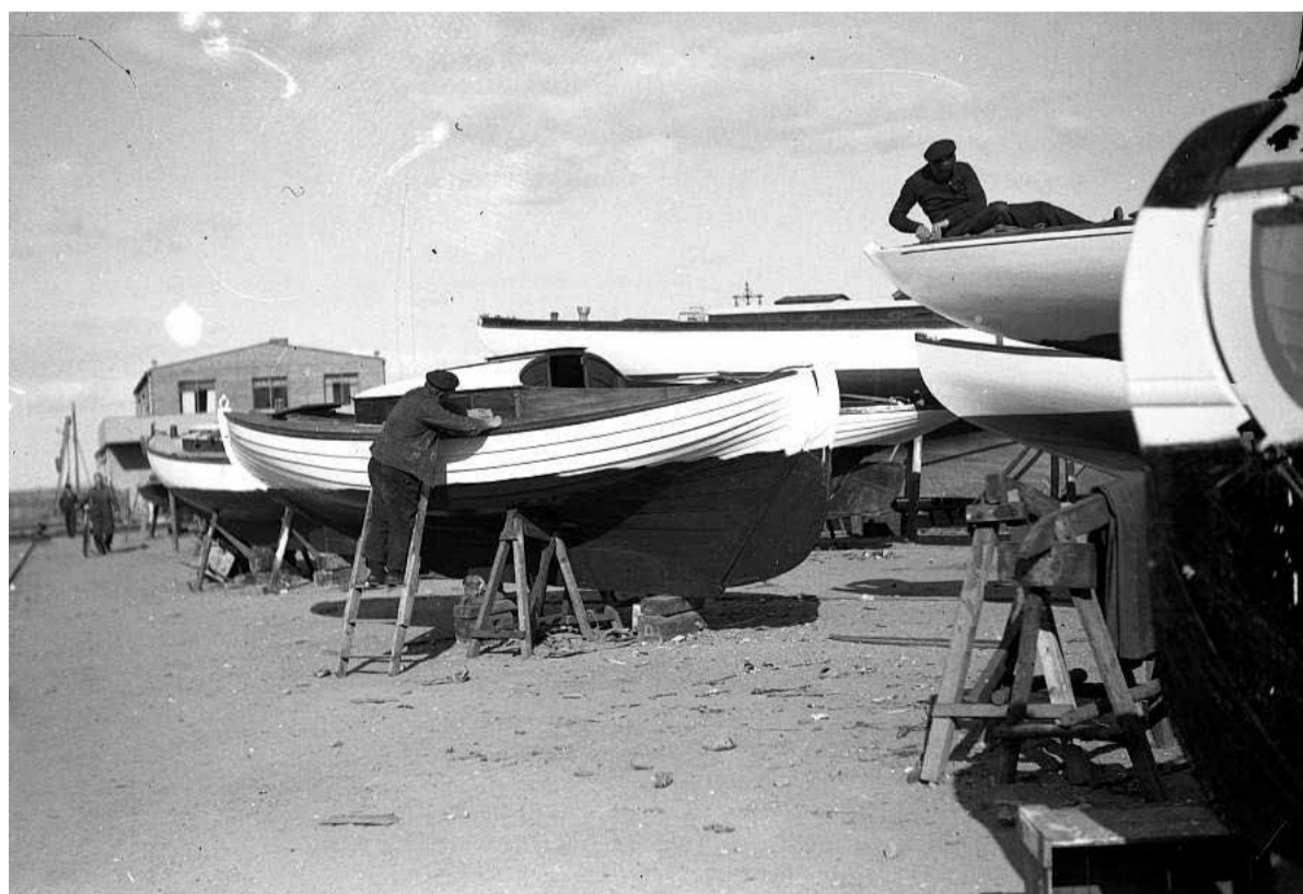
En efterårsstorm i 1928 og en vinterstorm i 1929 forsinkede arbejdet med den nye lystbådehavn voldsomt. I de følgende år skred arbejdet dog roligt fremad, og der blev lavet kajmur, dækmole, veje og skibs- og bådebedding. 14. maj 1933 blev lystbådehavnen endeligt indviet ved en stor fest med flere tusinde deltagere. Den havde kostet godt 2 millioner kr., svarende til ca. 80 millioner kr. i dag. På billedet bliver lystbåde gjort forårklar ved den nye lystbådehavn i midten af 1930'erne. Foto: Aage Fredslund Andersen, ca. 1935, Aarhus Stadsarkiv.
