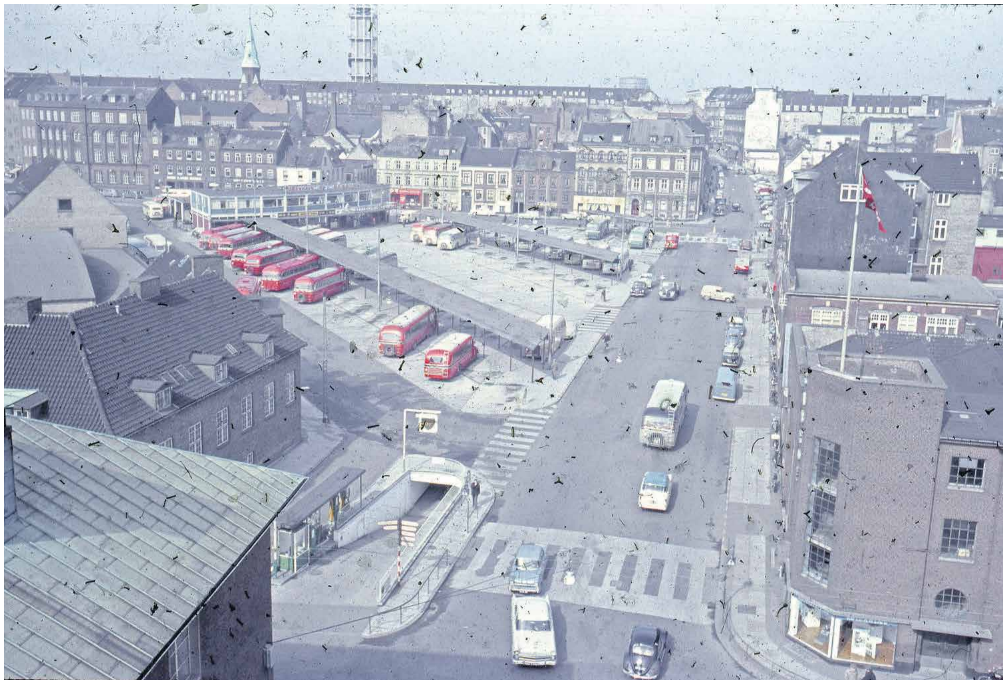
Rutebilstationen efter udvidelsen fotograferet i slutningen af 1950'erne. Busserne er sidenhen blevet udskiftet med nyere modeller, men ellers er der ikke sket store forandringer på stationen de sidste godt 60 år. Foto: Stadsingeniørens Kontor, ca. 1957-1958, Aarhus Stadsarkiv
