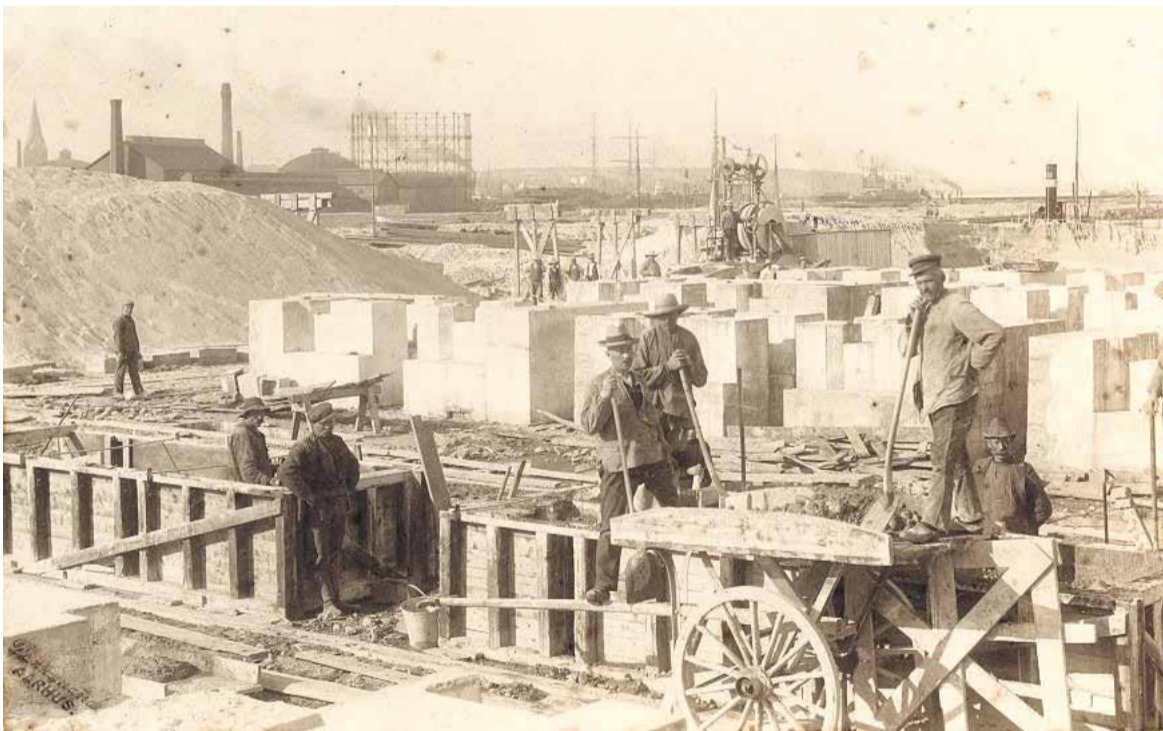
Sydhavnen under anlæggelse i 1911. Ukendt fotograf, Den Gamle By.
