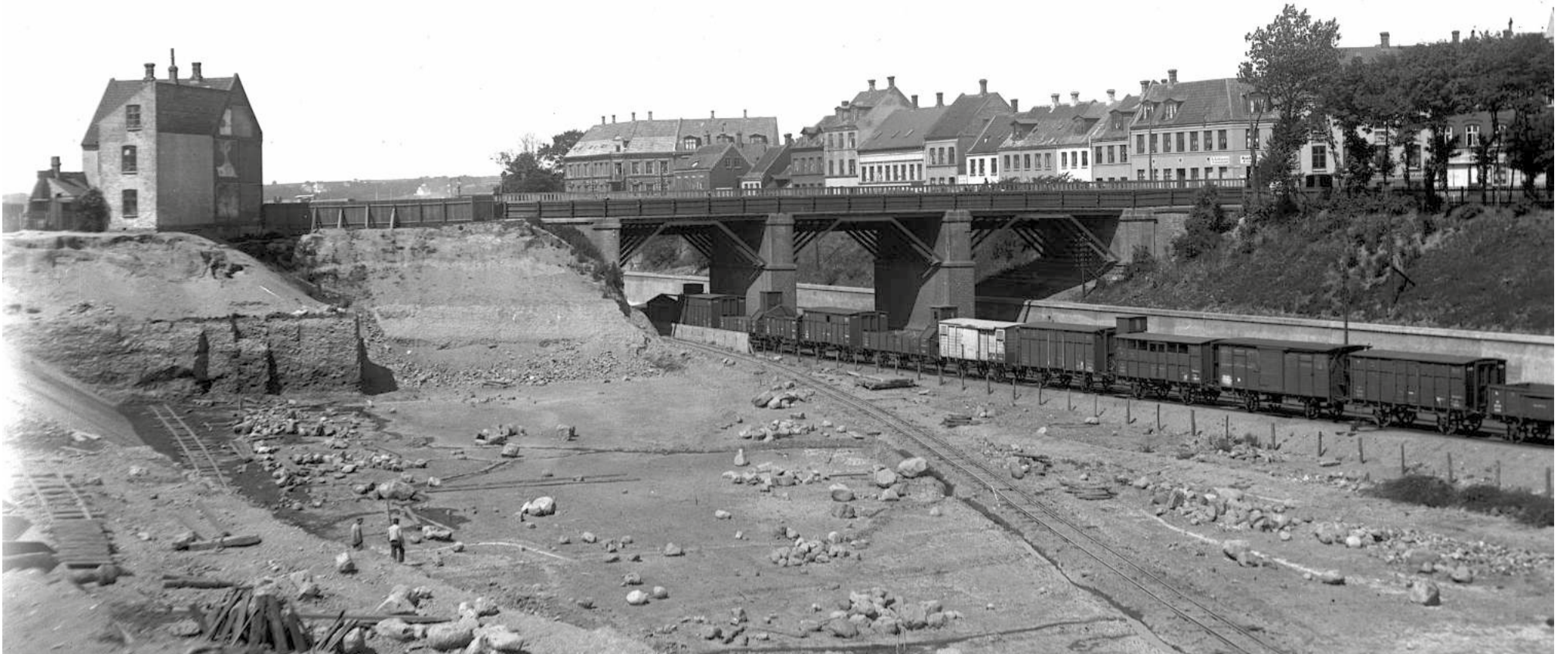
Blot 60 år efter jernbanen blev anlagt i byen, var banegraven for lille og måtte udvides. Udvidelsen gik blandt andet ud over Hallsvej, der blev decimeret til Hallssti (beliggende lige uden for billedets venstre side). Også den gamle Frederiksbro, der ses på billedet, måtte udskiftes med en større. I højre side af billedet ses Morten Børups Gade. Foto: Hammerschmidt Foto, 1922, Aarhus Stadsarkiv.
