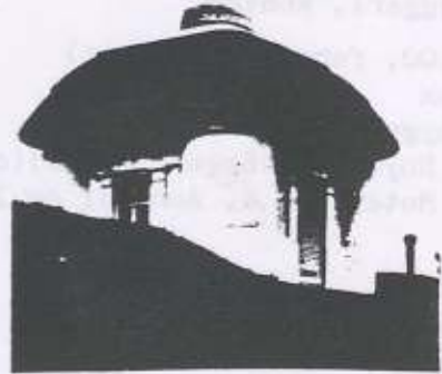
Chr. Molbechsvej, Højde- beholder. Med det hus kom jernbetonen til Århus
